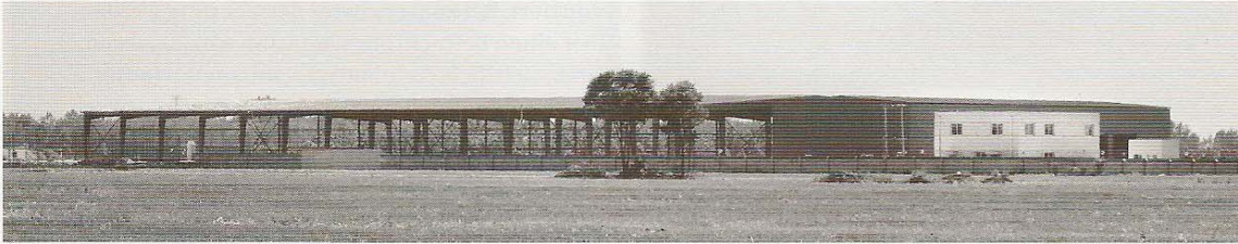
Abbildung 2 Gesamtansicht der MBA, im Vordergrund die neue Deponie
