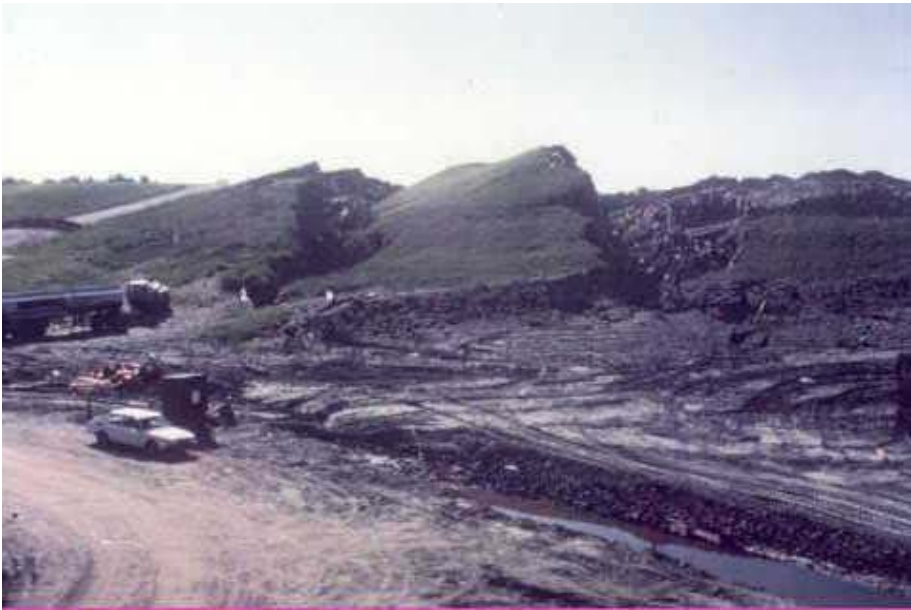
Fig. 1: landfill failure - Maine (USA), 1989
